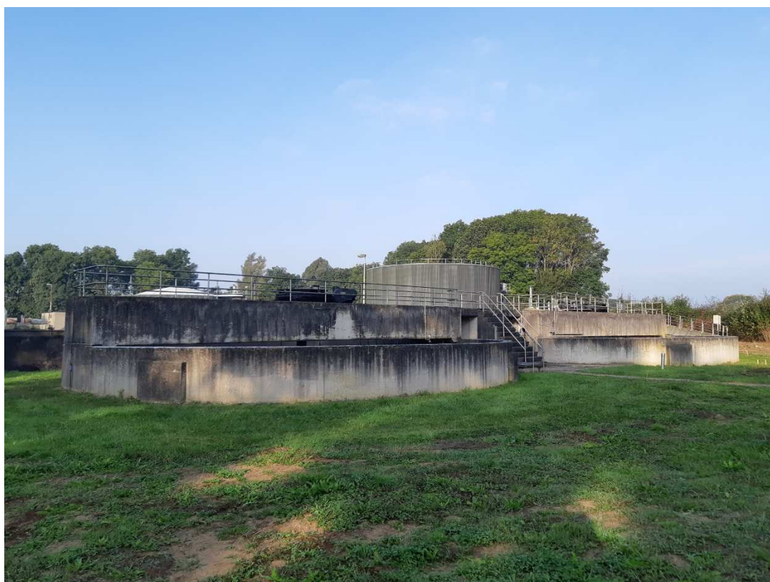
Afbeelding 6: De slibbindickers.
