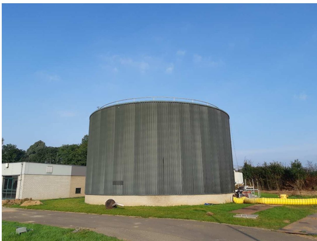
Afbeelding 4: De slibgistingstank die wordt omgebouwd tot slibbuffer.
