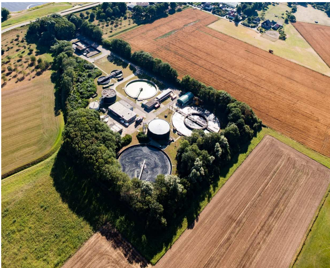
Afbeelding 1: Luchtfoto van de huidige rwzi Terwolde
