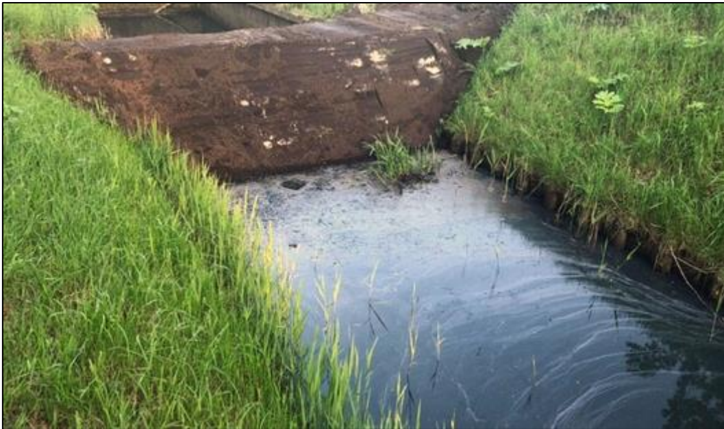
Figuur 7: Voorbeeld van afgesloten watergang met gronddam.
