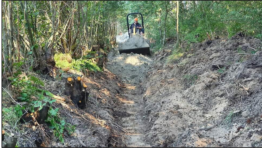
Figuur 8: Voorbeeld van verhogen slootbodem.
