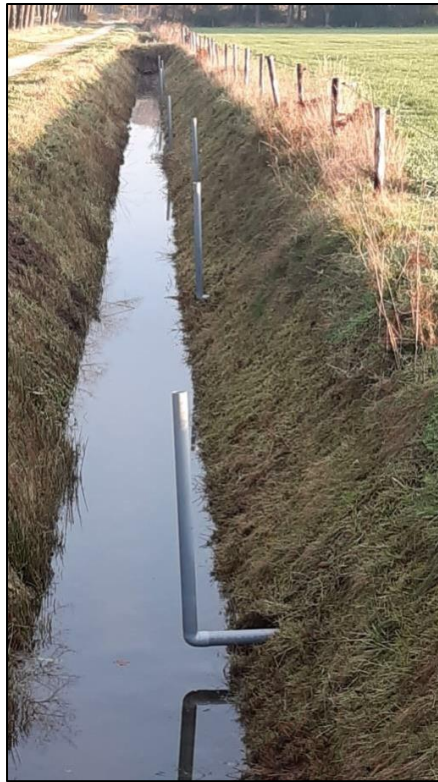
Figuur 6: Voorbeeld van draaibare bochten op bestaande drainagebuizen.
