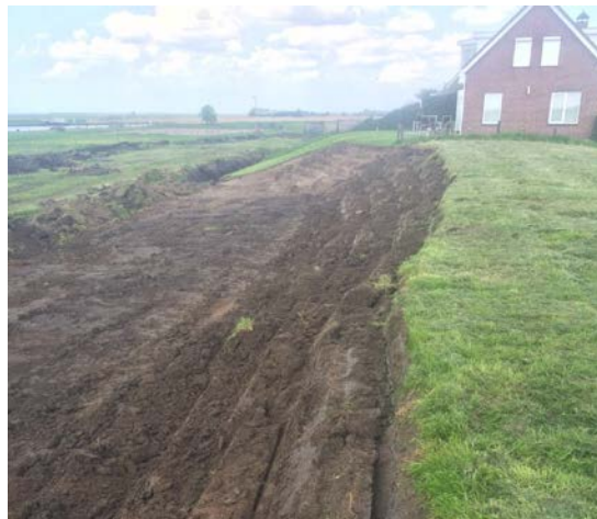
Foto: Graafwerkzaamheden bij 't Overvaren
